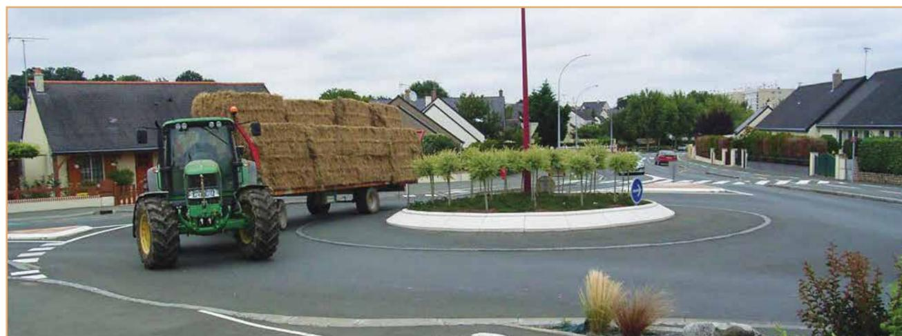
Les mini-giratoires sont à réserver dans les espaces contraints, à la condition que les vitesses d'approche soient déjà modérées. Ce type de rond-point « à plat » permet un franchissement aisé des engins agricoles, tout en limitant le franchissement des véhicules légers par la mise en place de bordures périphériques, de plots ou de dispositifs sonores.
